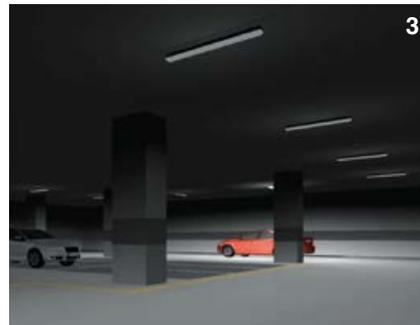
3 Quando non viene rilevato alcun movimento e trascorso il tempo di attesa, il sensore dimmerà la luce al livello di luminosità preimpostato (10% o 30% di luminosità).
