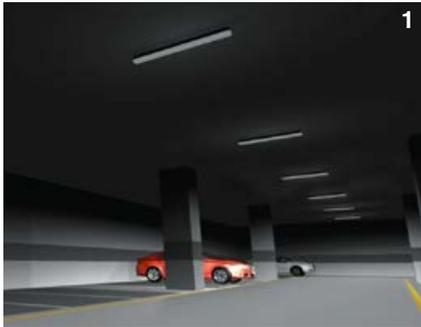
1 Quando non viene rilevato alcun movimento, la luce rimane accesa al livello preimpostato (10% o 30% di luminosità).
